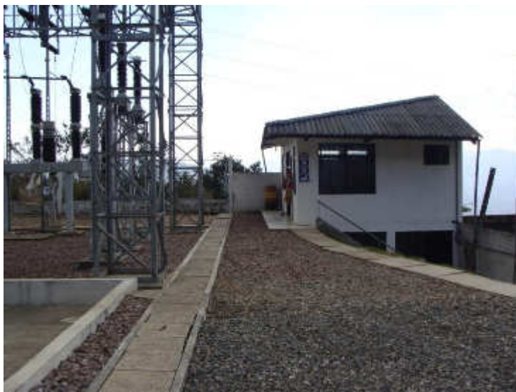
Foto 29. Subestación eléctrica Cariamanga.
