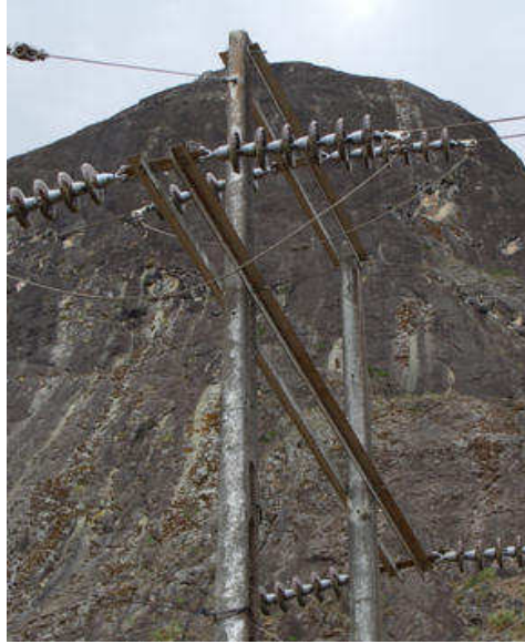
Foto 27. Estructura de la línea de Sub-transmisión Gonzanamá – Cariamanga.
