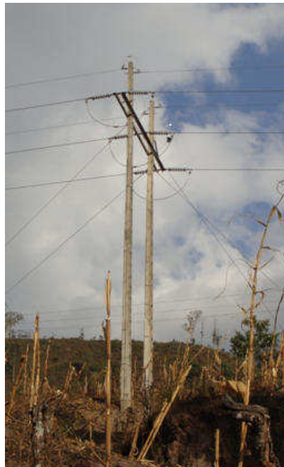
Foto 28. Estructura de la línea de Sub-transmisión Cariamanga - Macará.
