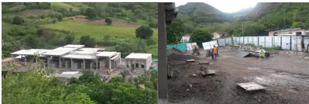
Foto 25. Construcción del "Hospital del Lucero"
